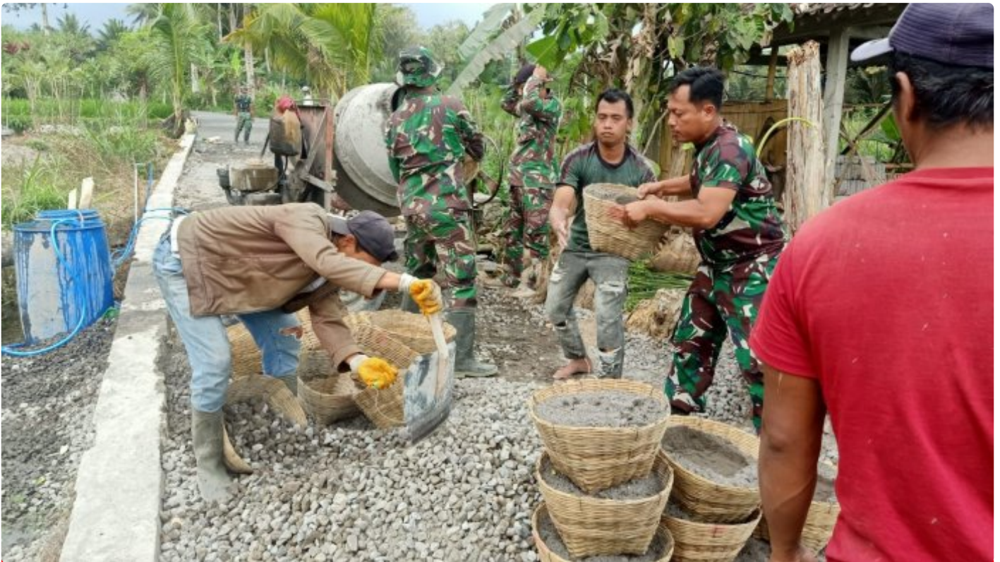
Satgas TMMD Sengkuyung bersama warga bahu membahu mengerjakan cor blok jalan
